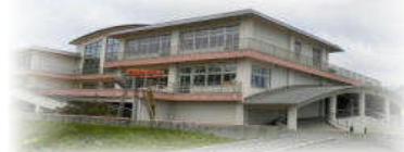
奥尻町立青苗小学校
